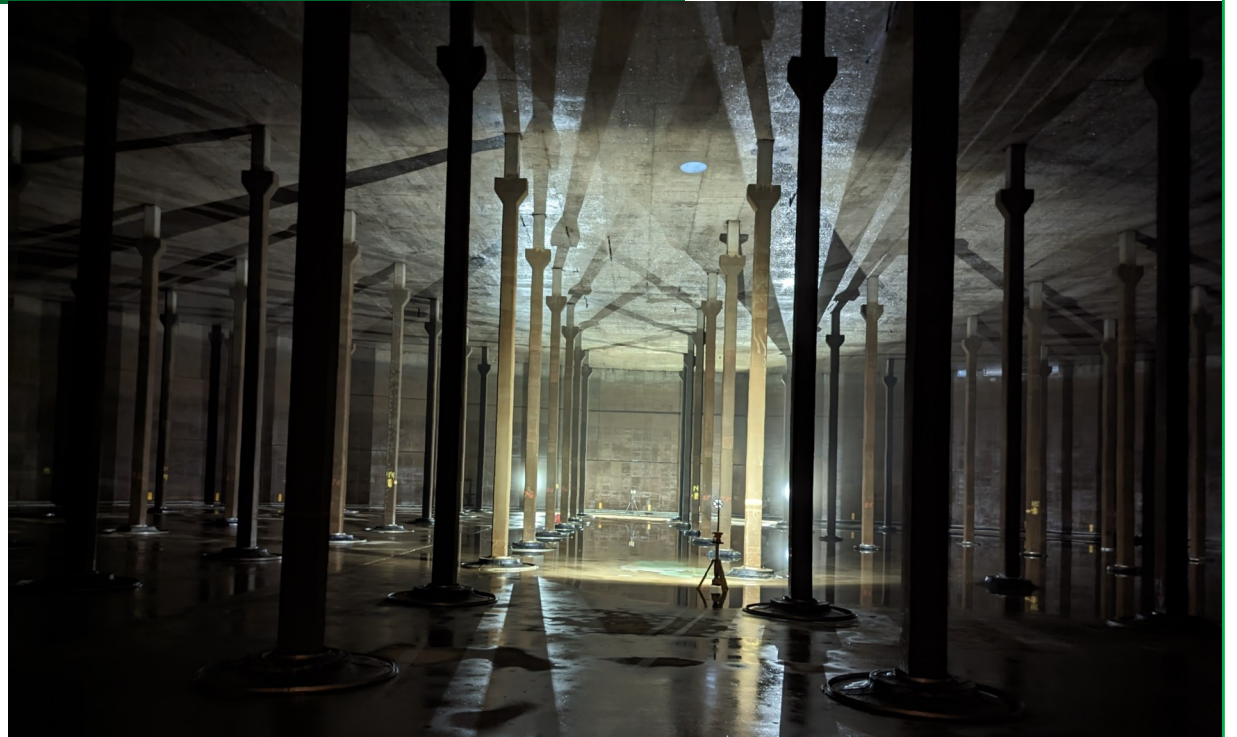
Figura 1: Interior del reservorio de 8 millones de galones, observando algunos de los 109 pilares.
