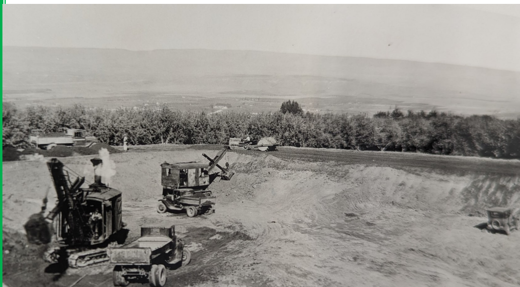
Figura 2: Fotos de la construcción del reservorio de 4 millones en 1931. Usted puede observar los motores de vapor en uso.
