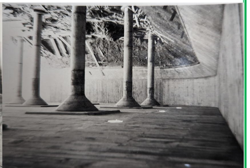
Figura 3: parte interior del reservorio de 4 millones construido en 1931. Estos pilares son similares a los que se pueden apreciar en el reservorio de 8 millones.
