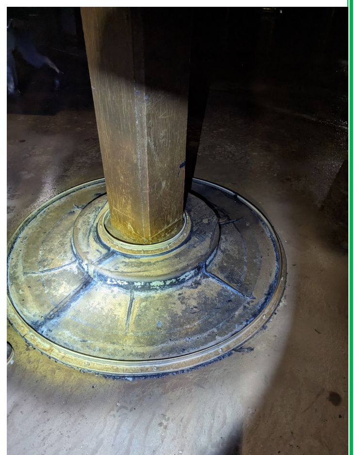
Figura 4: Pilar con la unión y las válvulas.
