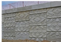
Textured wall treatment / Tratamiento de pared texturizado
