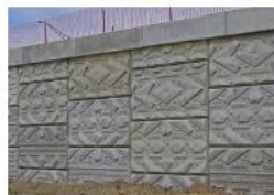
Textured wall treatment / Tratamiento de pared texturizado
